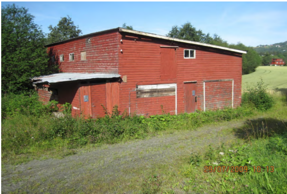
På den omsøkte parsellen ligger det i dag en eldre bygning som søker omtaler som stoll. Bygningen ligger for seg selv og noe avskjermet fra øvrig bebyggelse på eiendommen. Bygningen grenser mot dyrka mark.
